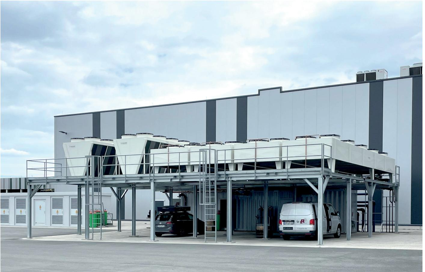
Die Kondensatoren für die Abführung der Abwärme wurden platzsparend auf einer Bühne montiert.
