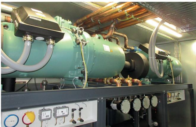
Bild 2: Der Leistungsbedarf der Kälteversorgung ist auf vier identische Kältemaschinen mit je 550 kW Kühlleistung aufgeteilt, die jeweils in einem Container untergebracht sind.
