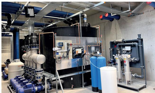
Üblich bei der Kälteversorgung von Extrusionsanlagen: die Pumpen-Tank-Kombination im Keller
