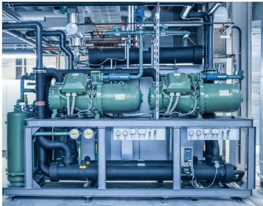
deshalb ein wichtiger Faktor, weil die Kunden preissensibel sind und große Mengen von exakt temperiertem Kühlmedium benötigt werden, wie die Gesamtleistung der Anlagen nach der zweiten Ausbaustufe zeigt: 1,2 MW für die Werkzeugkühlung, 2,35 MW für die Hydraulikkühlung und für die Freikühler zur Winterentlastung. Das entspricht 50% der Kühlleistung des geplanten Gesamt-Endausbaus. Mindestens ebenso wichtig ist aber die präzise und stets
