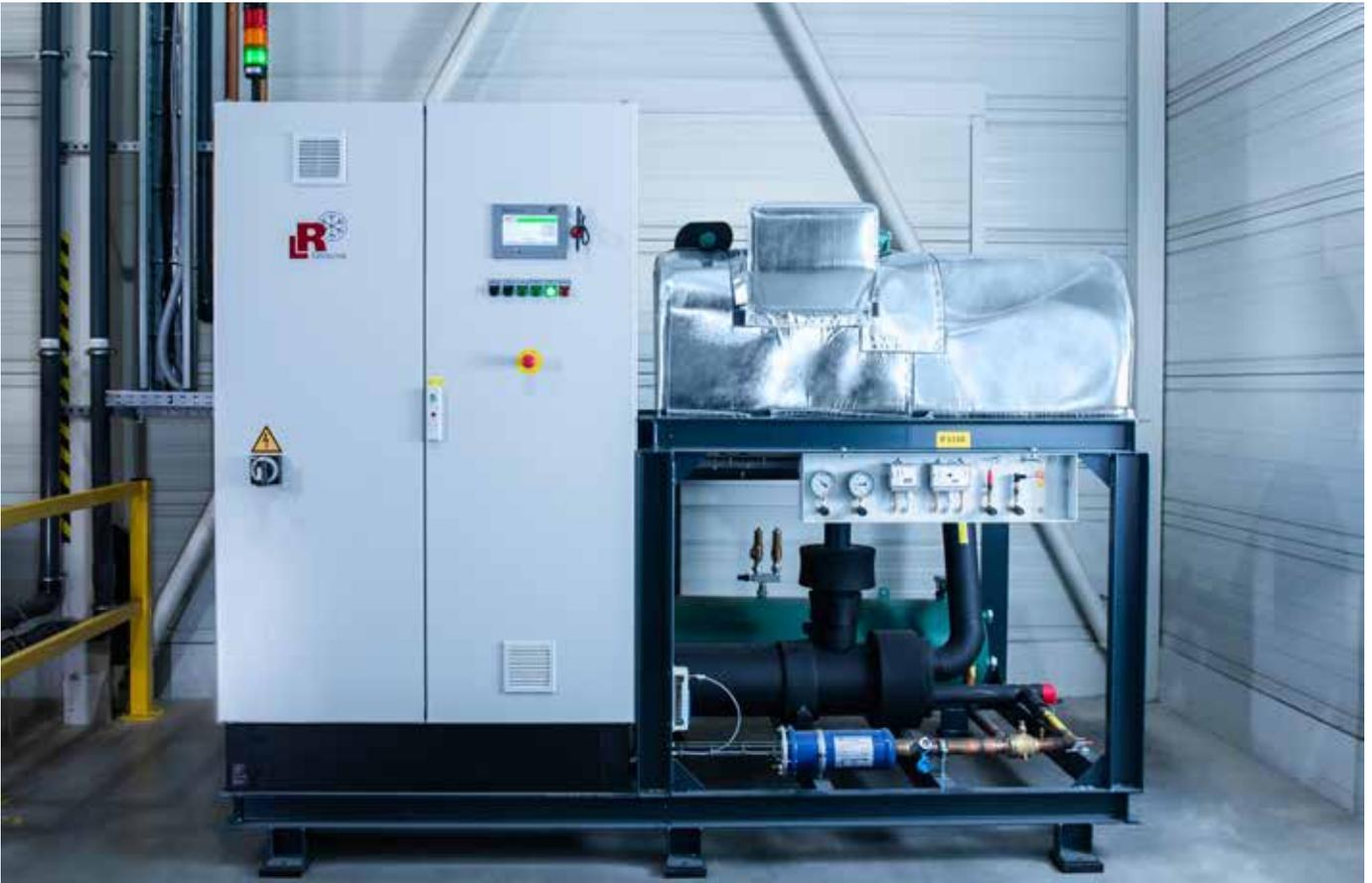
L&R Splittkältemaschine mit 160 kW und Schraubenverdichter mit Schallschutzhaube.
