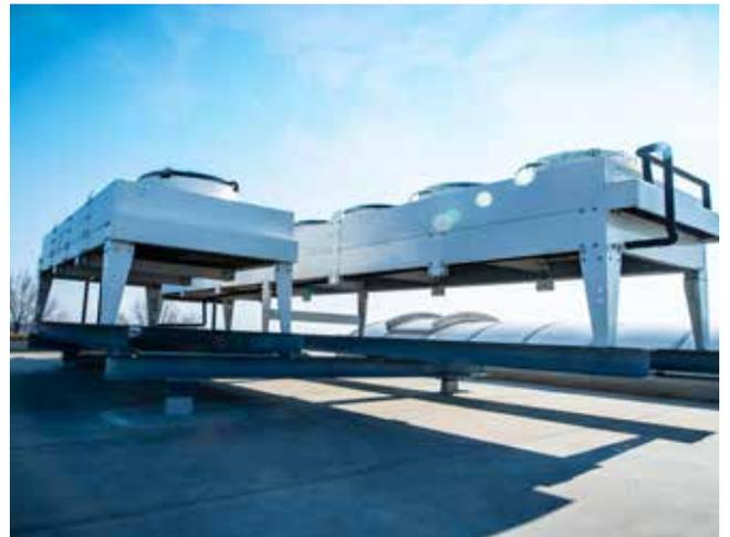
Kondensator der Splitkältemaschine und Freikühler mit einer Leistung von 240 kW.
