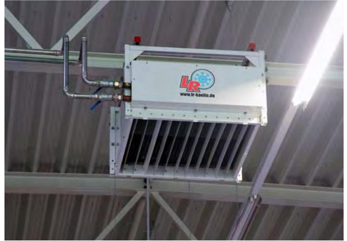
*Die im Hydraulikkreis entstehende Wärme wird für die Hallenbeheizung genutzt.*
