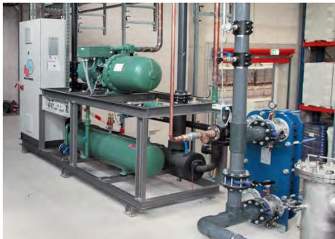
Die neue Split-Kälteanlage liefert Kälte für die Werkzeugkühlung der Spritzgießmaschinen.
