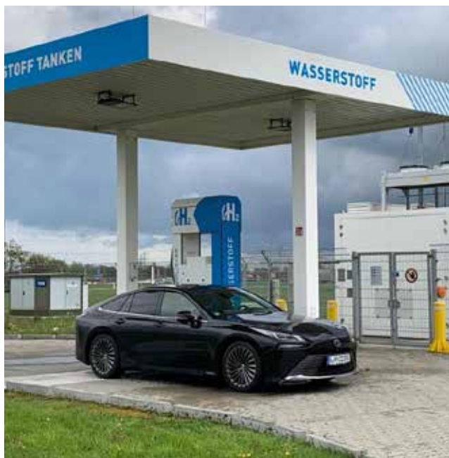
Im Hintergrund dieser Wasserstoff-Tankstelle ist die Kältemaschine mit der Wasserstoffaufbereitung gut zu sehen. (©: H 2 Mobility)
