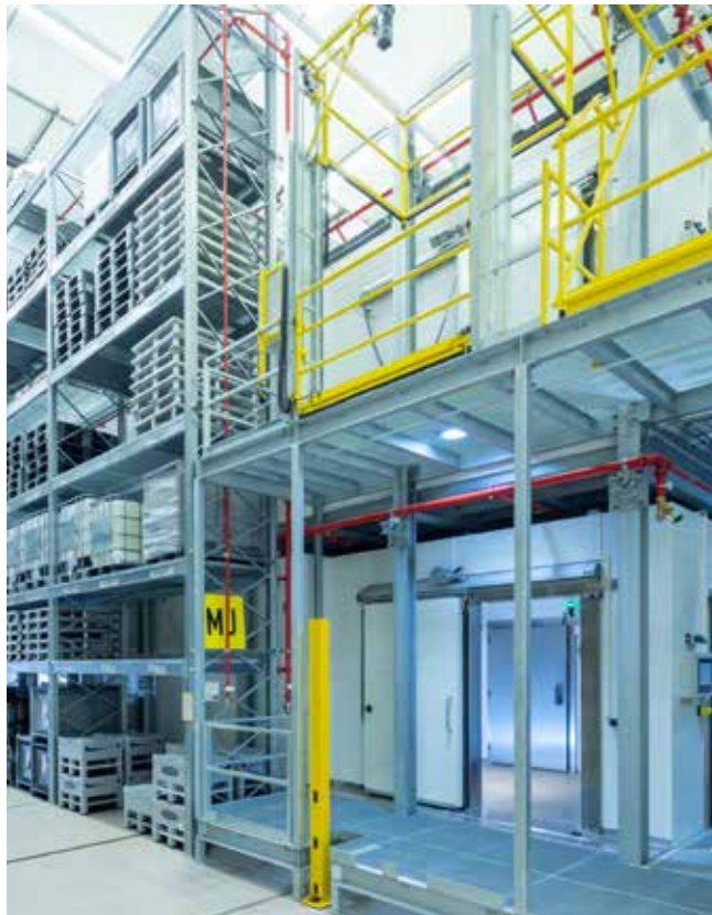
Das Tiefkühlager mit einer Fläche von 264 m 2 ist zweigeschossig aufgebaut.
