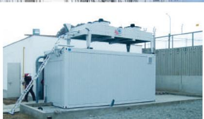
PERU - Splitkältemaschine im Container
