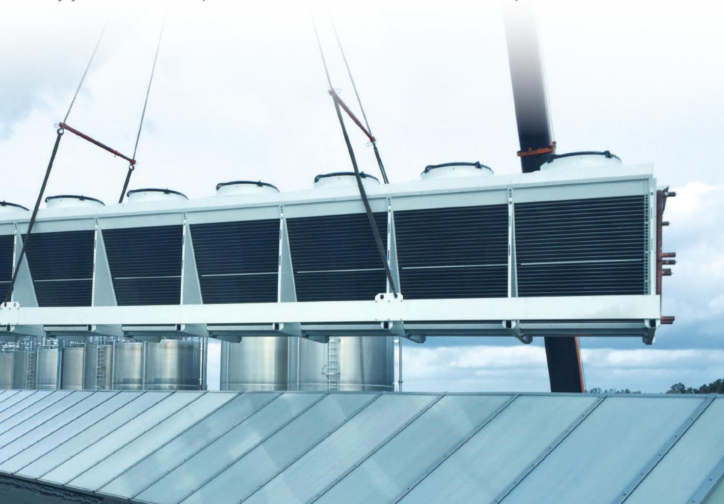
Spannender Moment: Die Kondensatoren der neuen Kälteanlage werden eingehoben.
