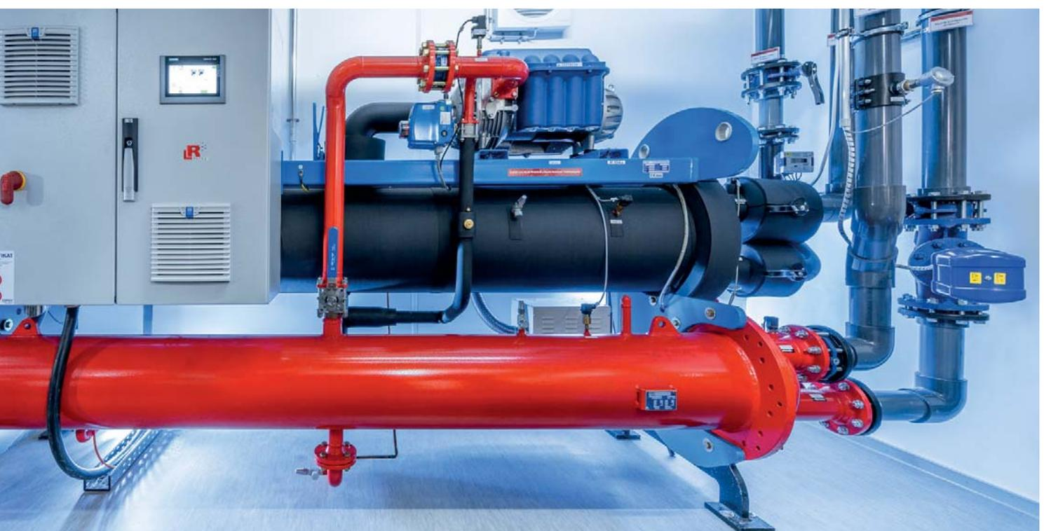
Die Turbocormaschine (Firma Engie) übernimmt die Grundlastversorgung und schafft eine zentrale Voraussetzung für die effiziente Kälteerzeugung.
