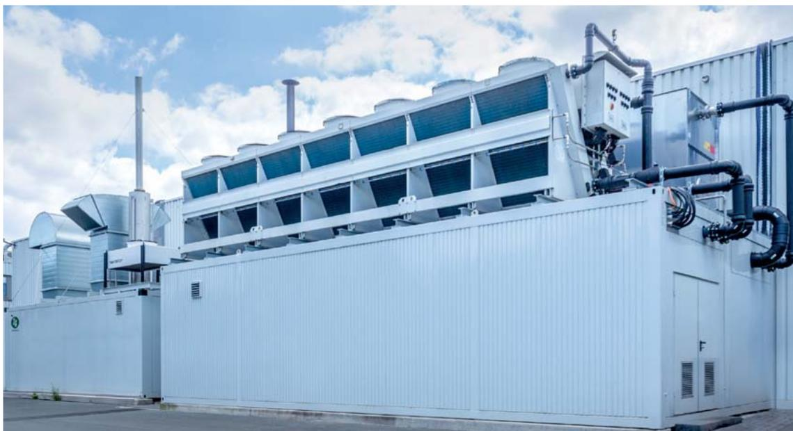
Containereinheit mit V-förmigen Freikühler inkl. Adiabatic
