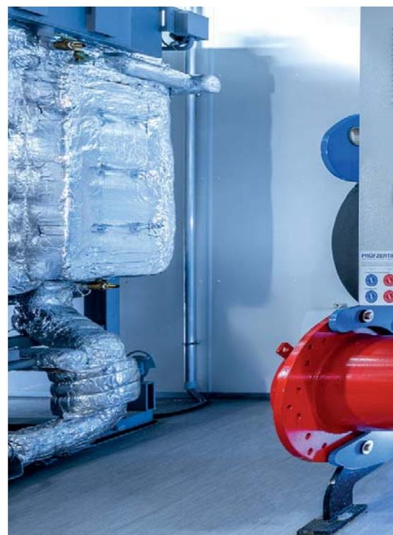
wassergekühlte Kältemaschine mit Turbocor-Verdichter und einer Kühlleistung von 400 kW abgedeckt. Sie arbeitet in einem großen Regelbereich sehr wirtschaftlich: eine ideale Spitzenlastmaschine.
