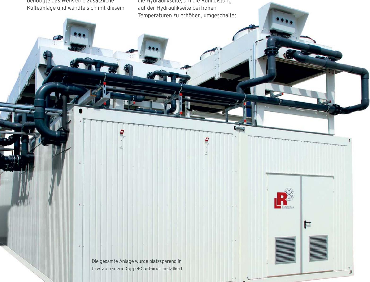
Die gesamte Anlage wurde platzsparend in bzw. auf einem Doppel-Container installiert.
