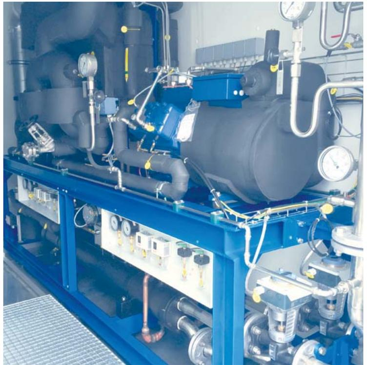
Die Container-Bauweise ermöglicht die weitestgehende Vormontage beim Anlagenhersteller
