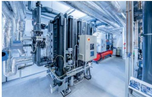
untergebracht, in dem die Behälter, Pumpen, Schaltschranke, die Absorptionskälte- und die Turbocormaschine montiert sind.
