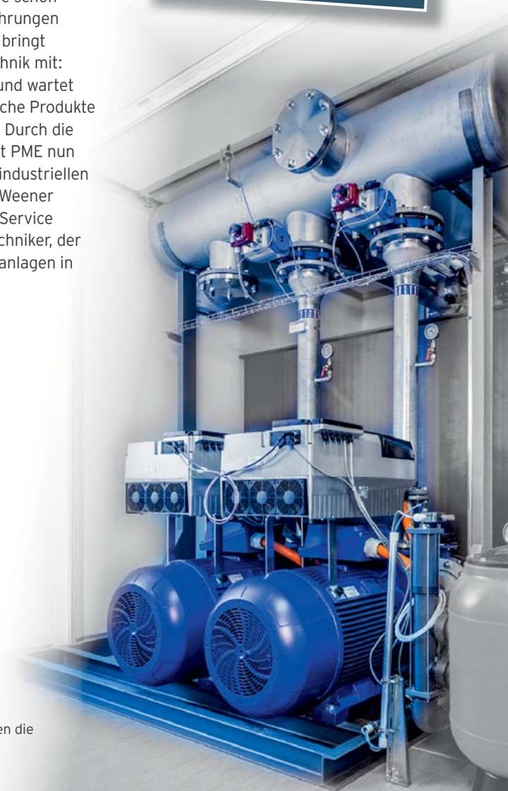
Die Doppelpumpen erhöhen die Verfügbarkeit der Anlage.
