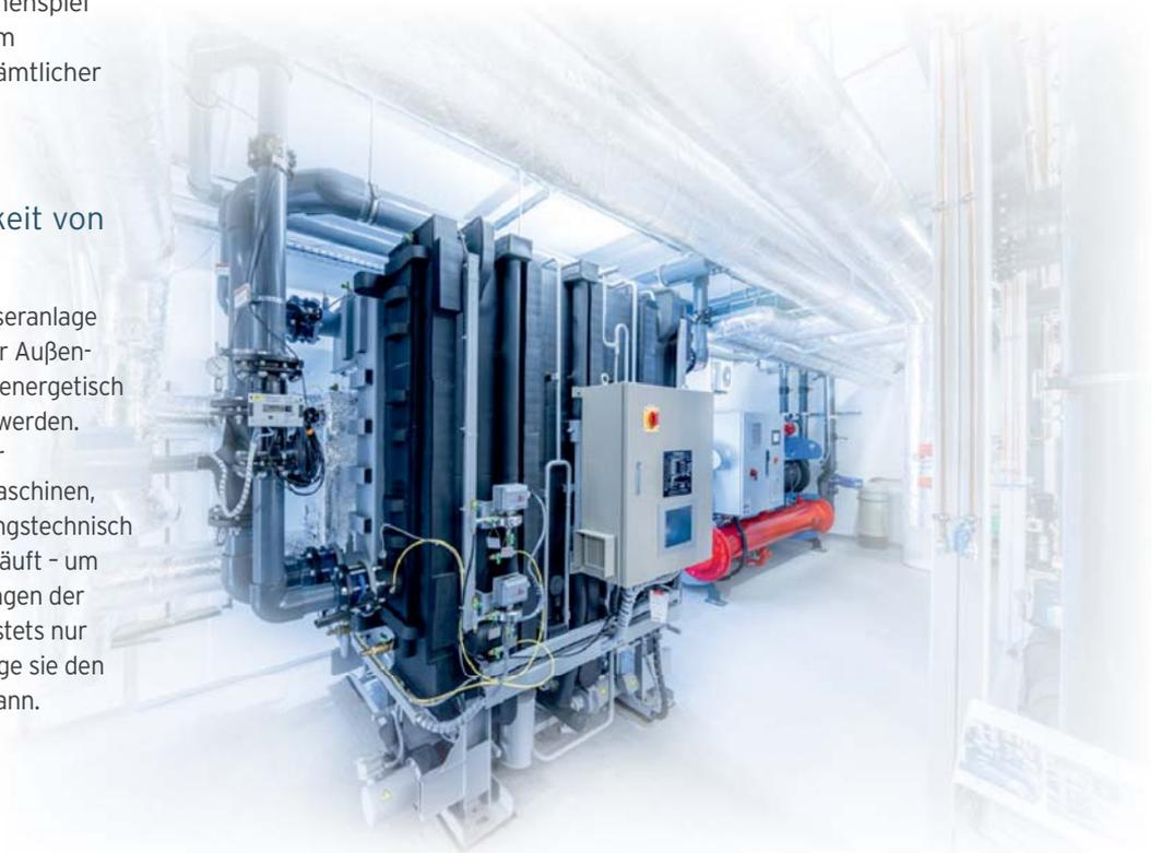
Die Absorptionskältemaschine wird im Sommer vom hauseigenen BHKW mit Wärme versorgt.
