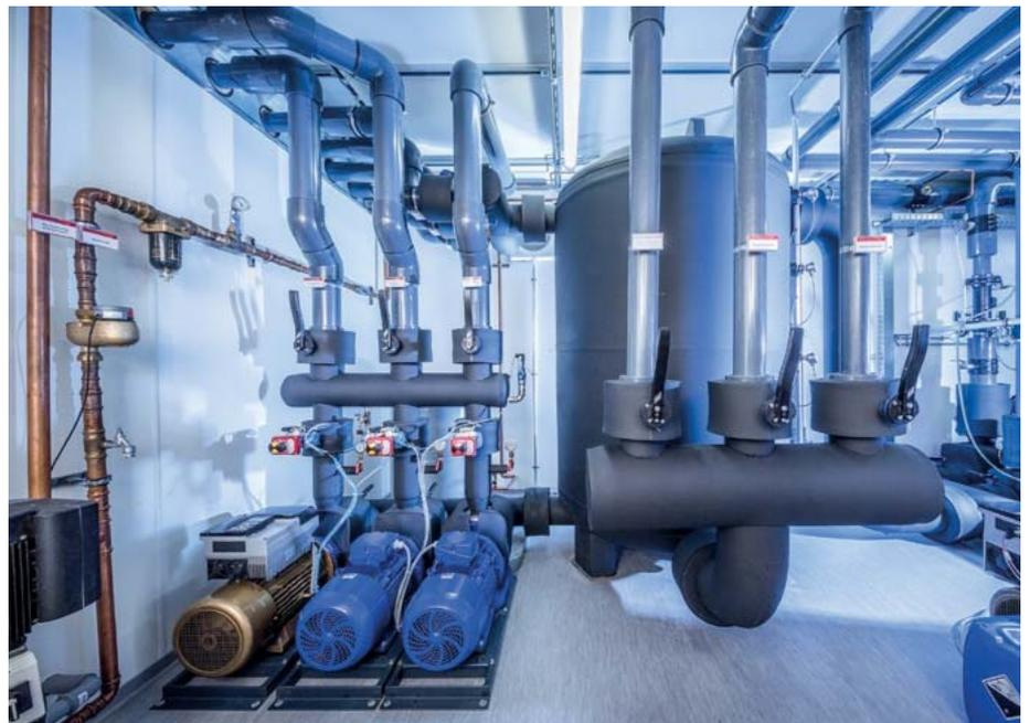
Blick auf die zentrale Pumpen-Tank-Einheit der Gesamtanlage, die aus drei Kälteanlagen mit jeweils unterschiedlichem Wirkprinzip besteht.
