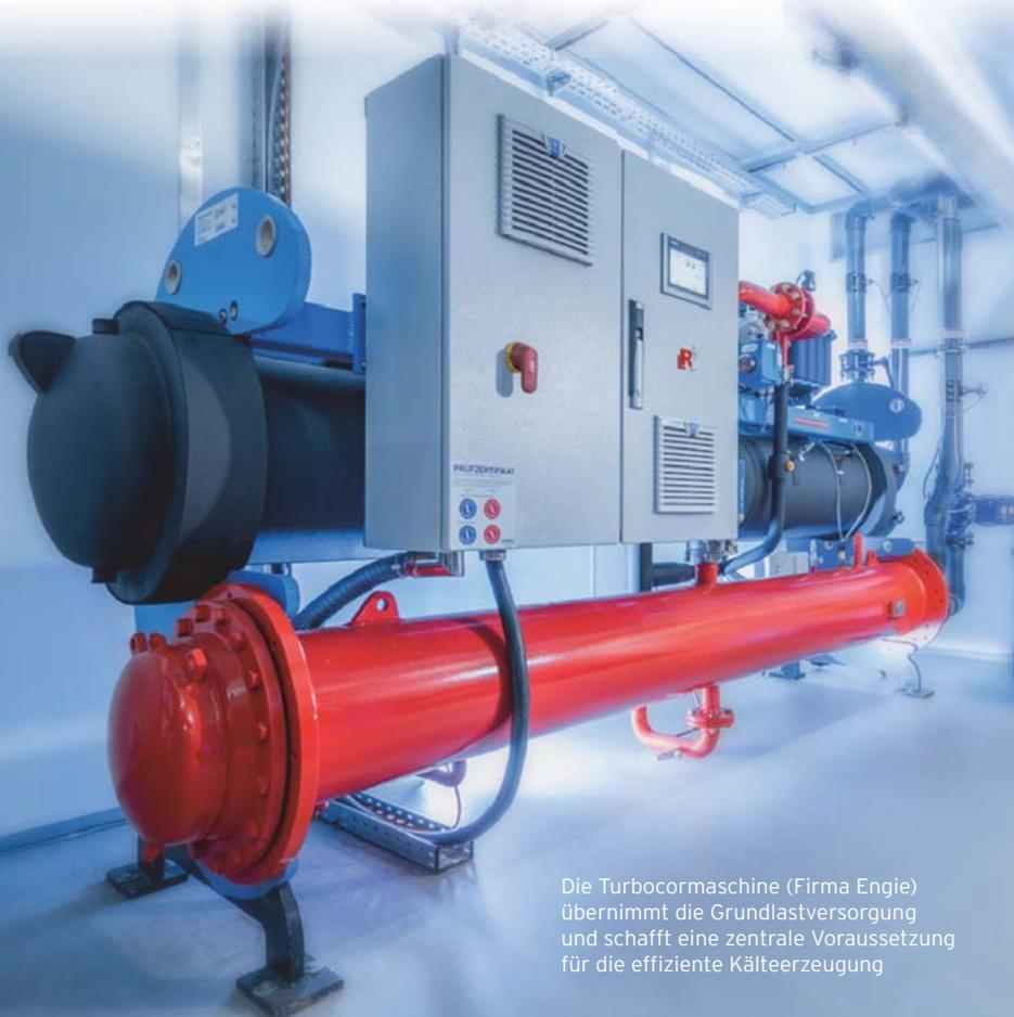
Die Turbocormaschine (Firma Engie) übernimmt die Grundlastversorgung und schafft eine zentrale Voraussetzung für die effiziente Kälteerzeugung
