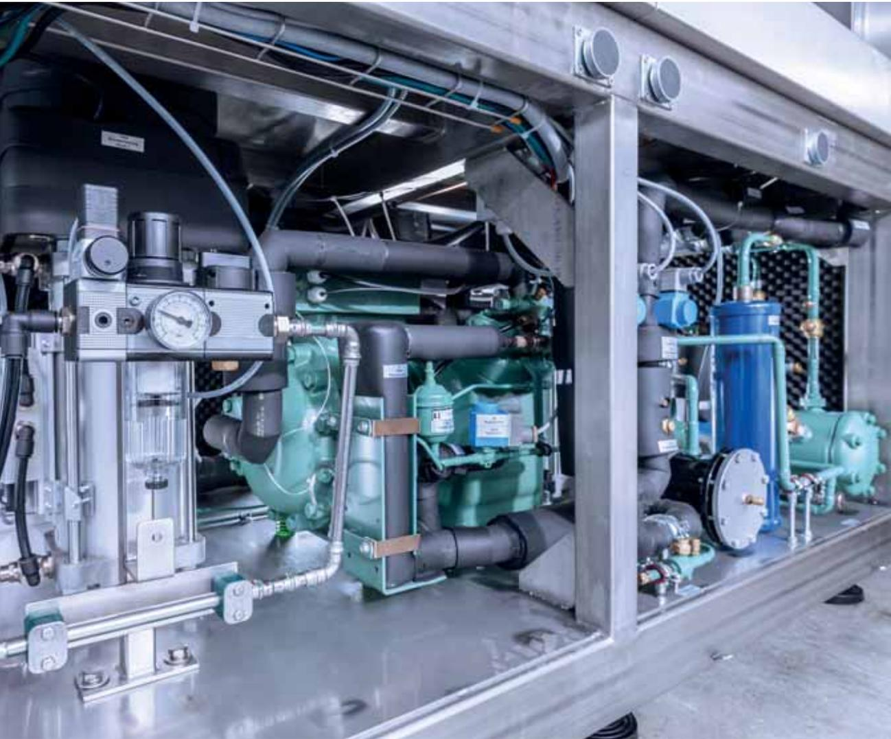
Kälteanlage für das „Gefrieren“ von Blutplasma
