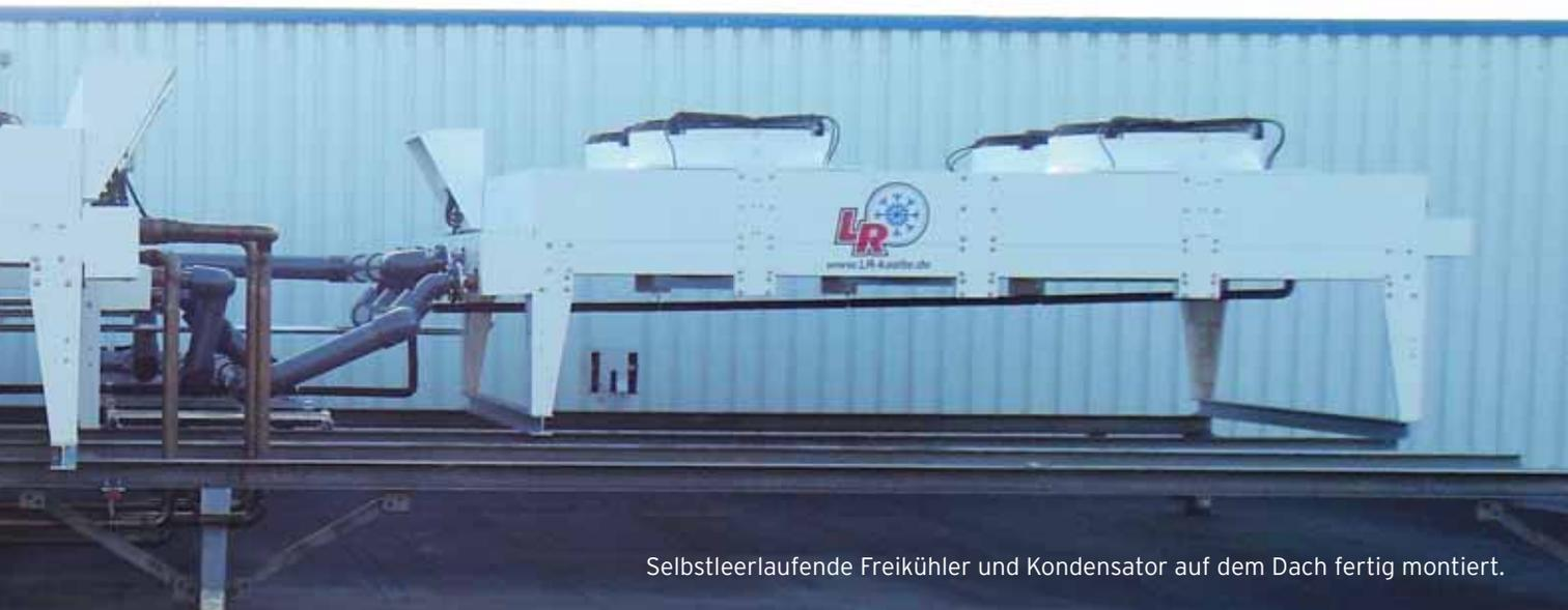
Selbstleerlaufende Freikühler und Kondensator auf dem Dach fertig montiert.
