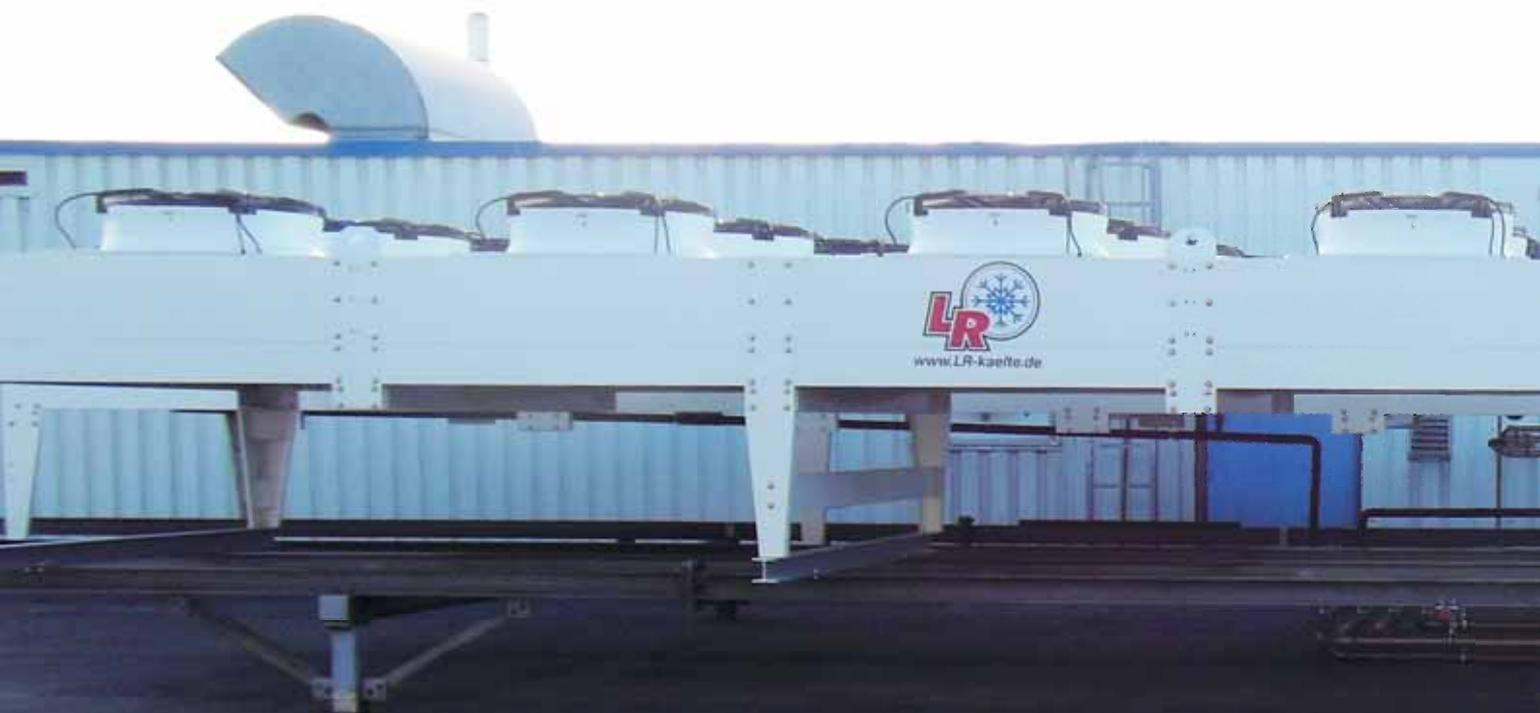
der Ventilatoren am Kondensator werden drehzahlregelt und somit bedarfsgerecht angesteuert.
